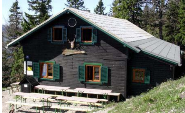
Die Gollerhütte jetzt
